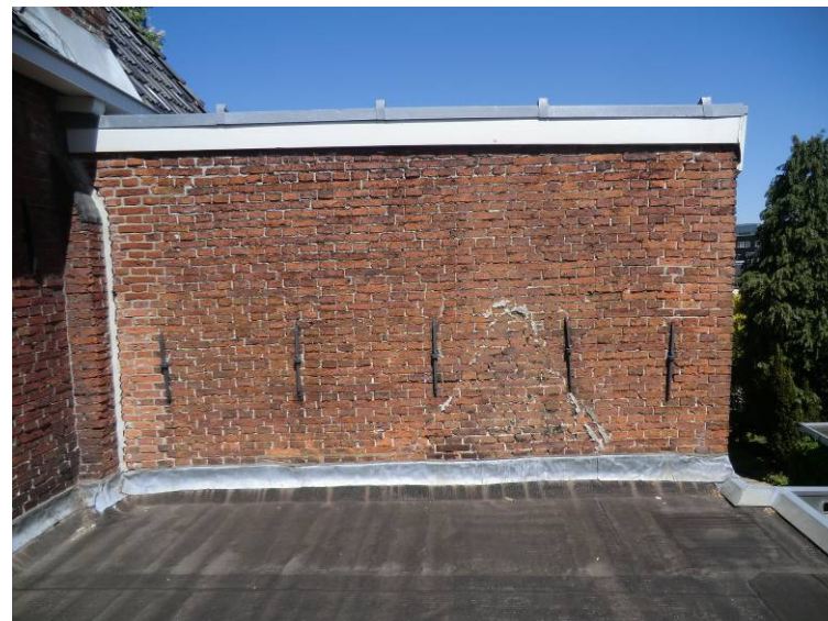
Aftekening van de mogelijk zeventiende-eeuwse kap van de turfzolder boven de keuken
