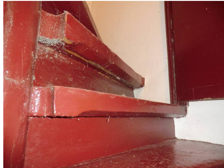
Verdieping, oude trappenhuis: detail treden met biljoenprofilering bovendeeel spiltrap
