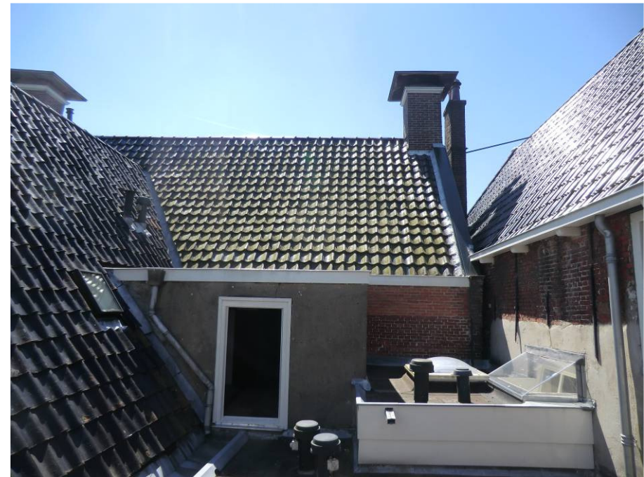
Achtergevel noord dwarspand met trappenhuis en dakvlak west van het langspand
