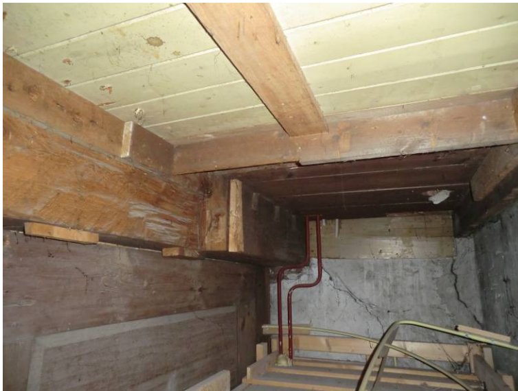
Zolder, achter bedsteewand voorkamer west: eiken moerbalk met inkepingen kinderbalken
