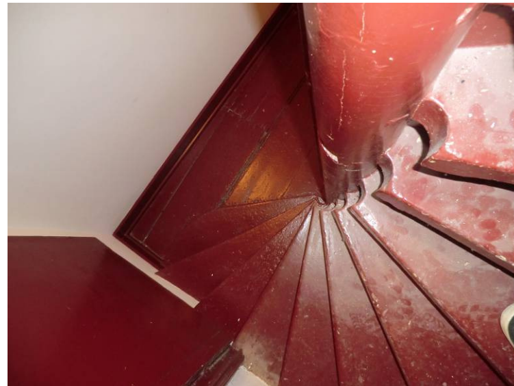
Oude trappenhuis: zeventiende-eeuwse trap, treden met half rond ingesnoerde hoeken
