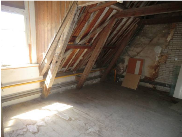
Kapconstructie dwarskap voorhuis: zuidzijde met kreupele stijlen en blokkelen.
