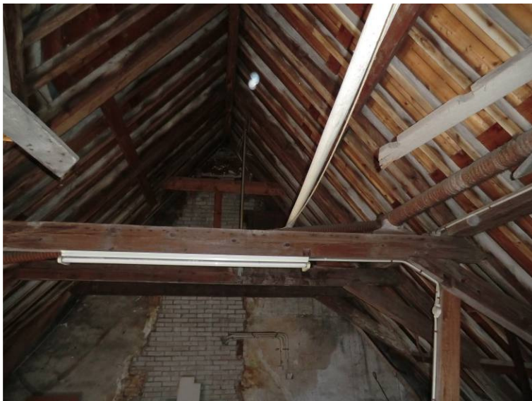
Kapconstructie dwarskap voorhuis: noordzijde met korbeels
