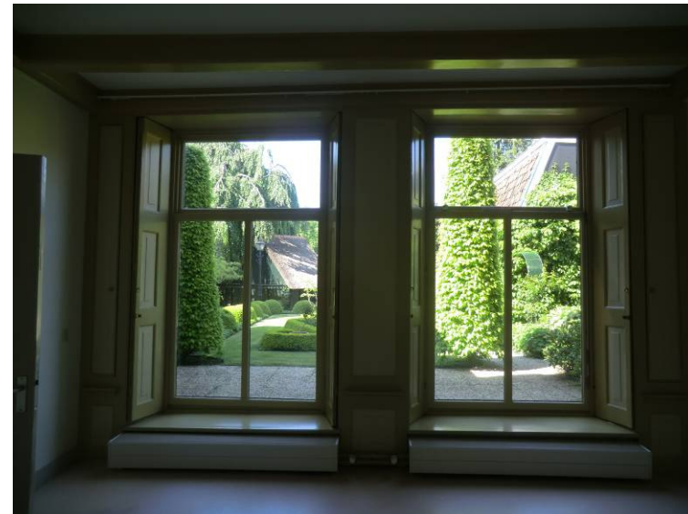
Begane grond, achterkamer oost: deels achttiende-eeuwse raampartijen in de achtergevel
