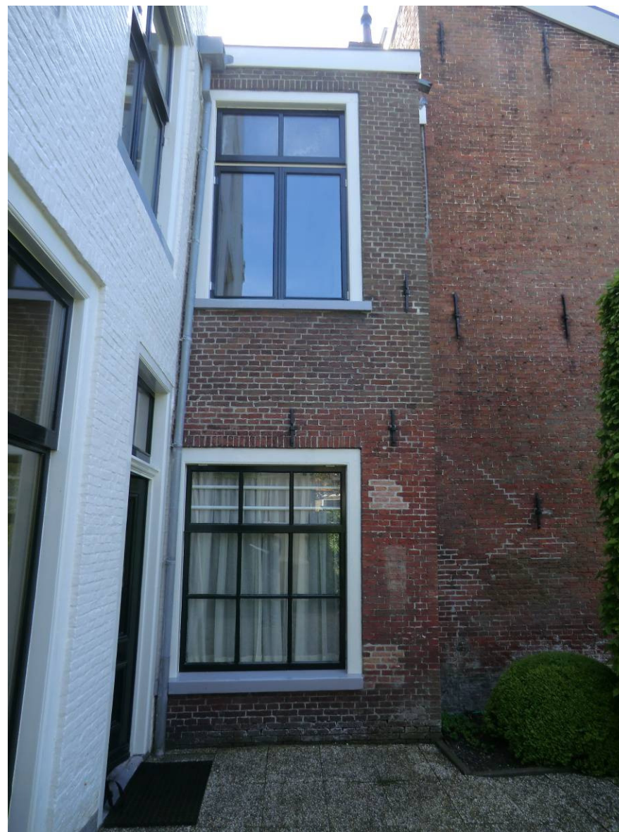
Zijgevel oost, uitbouw noordwesthoek
