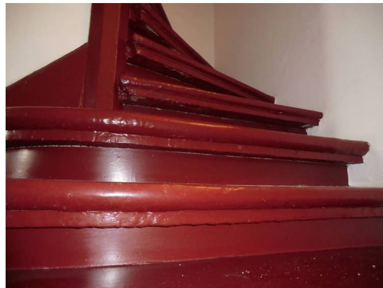
Begane grond, portaal: spiltrap (1713-1734) met zwaar uitgevoerde treden en achtkantige spil
