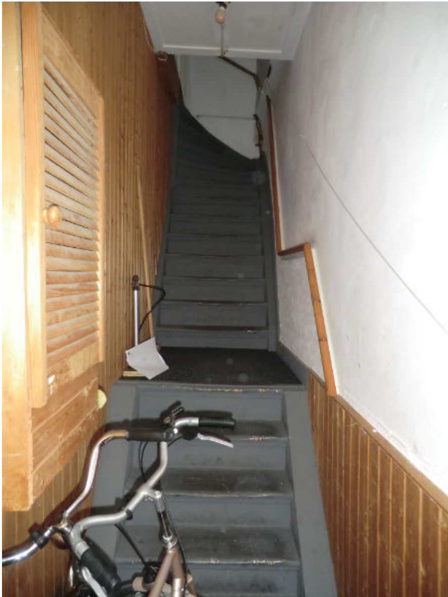
Langsgang voorhuis: steektrap met plat en kwart
