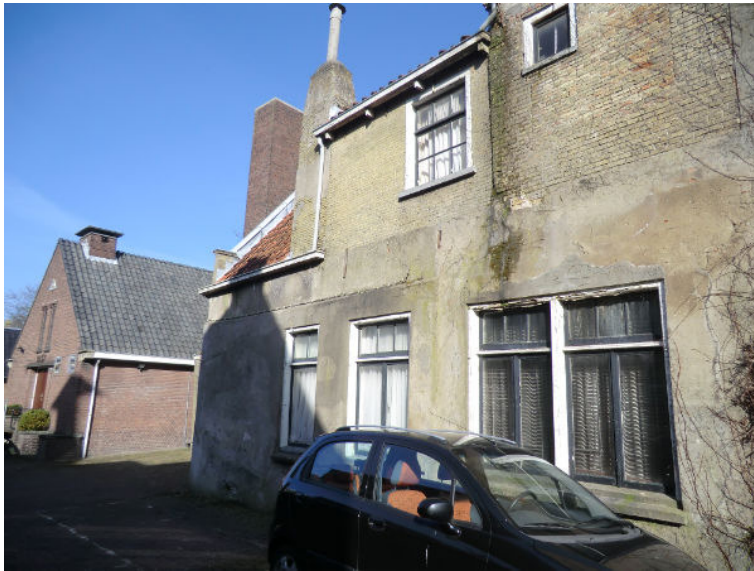
Zijgevel west: zicht op achterhuis met halve verdieping en herplaatste kozijnen
