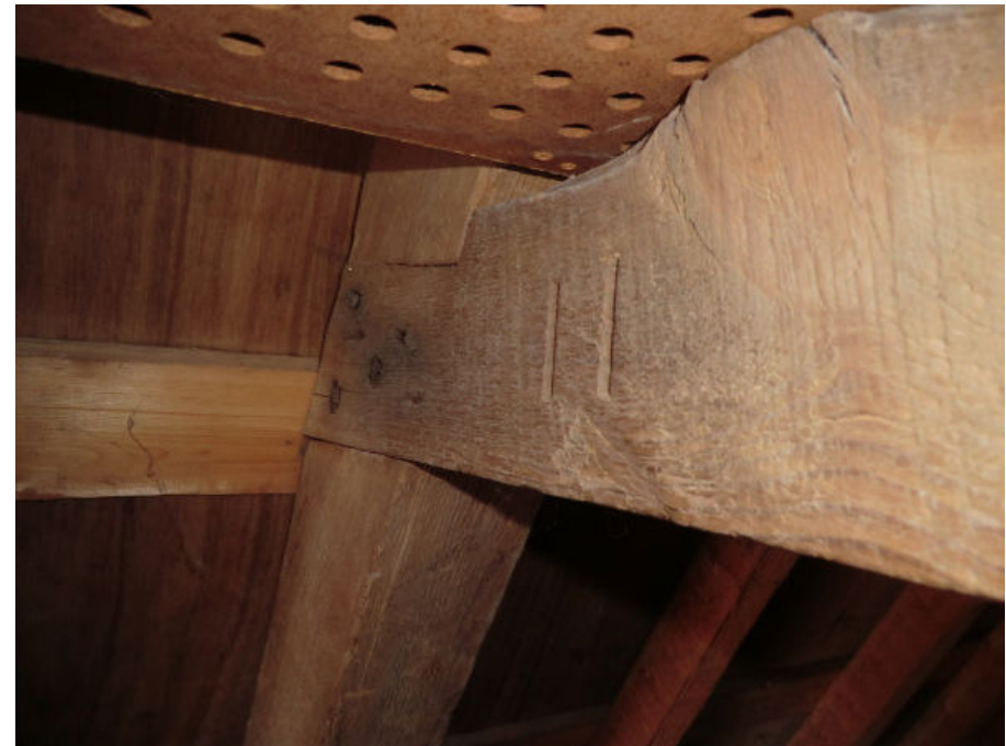
Zolder achterhuis: detail spantbeen en debalk met zwaluwstaart en gebeiteld telmerk II
