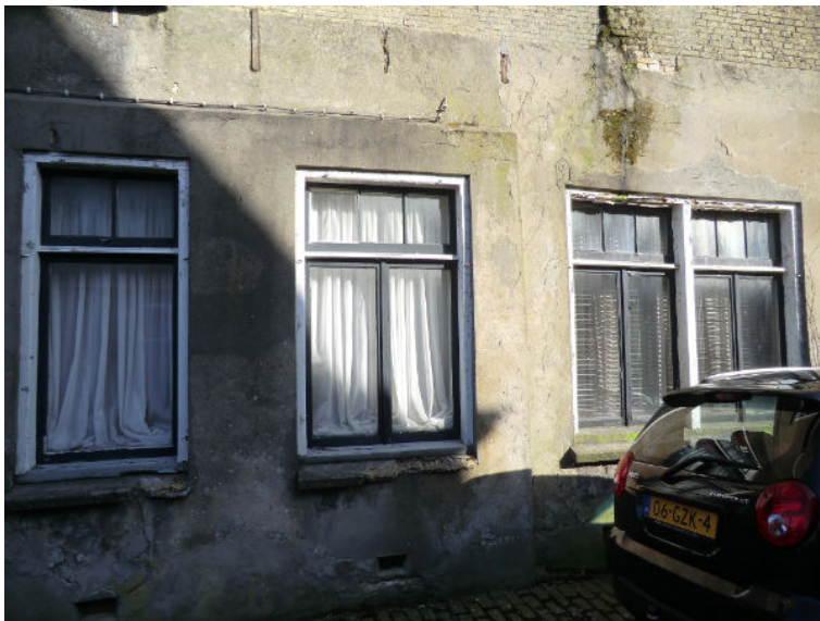
Achterhuis, zijgevel west: met dikker muurdeel ter hoogte van de begane grond
