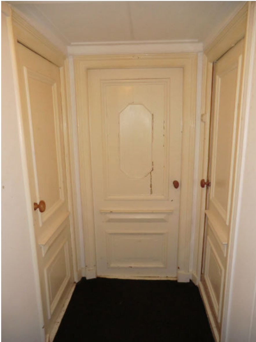
Achterhuis, verdieping: drie identieke paneeldeuren met omlijsting en neuten, 1737-1740
