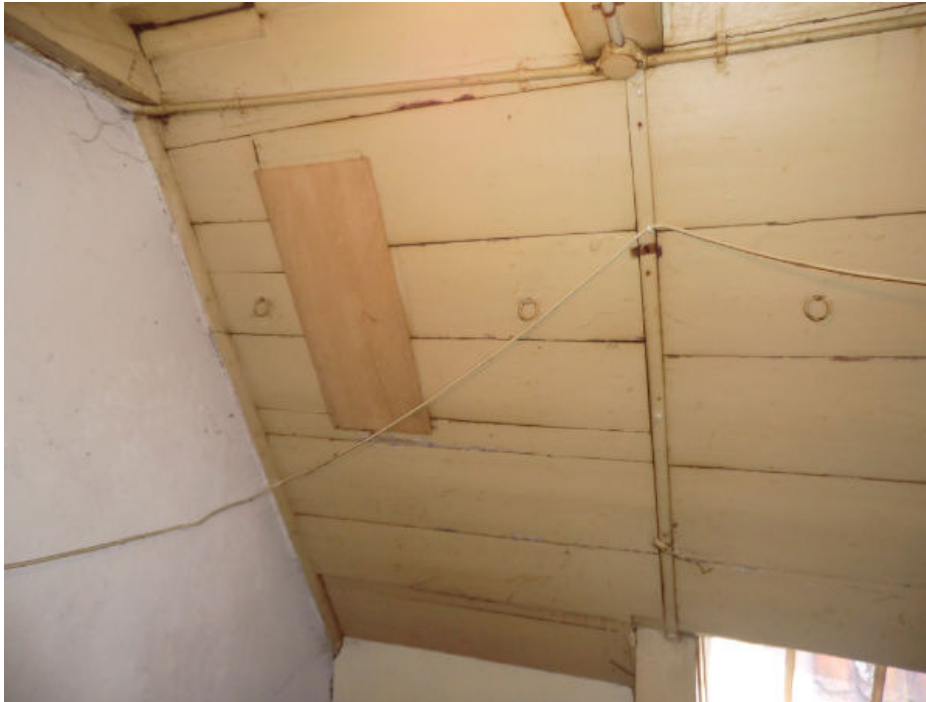
Zolder voorhuis met afneembaar dakbeschot
