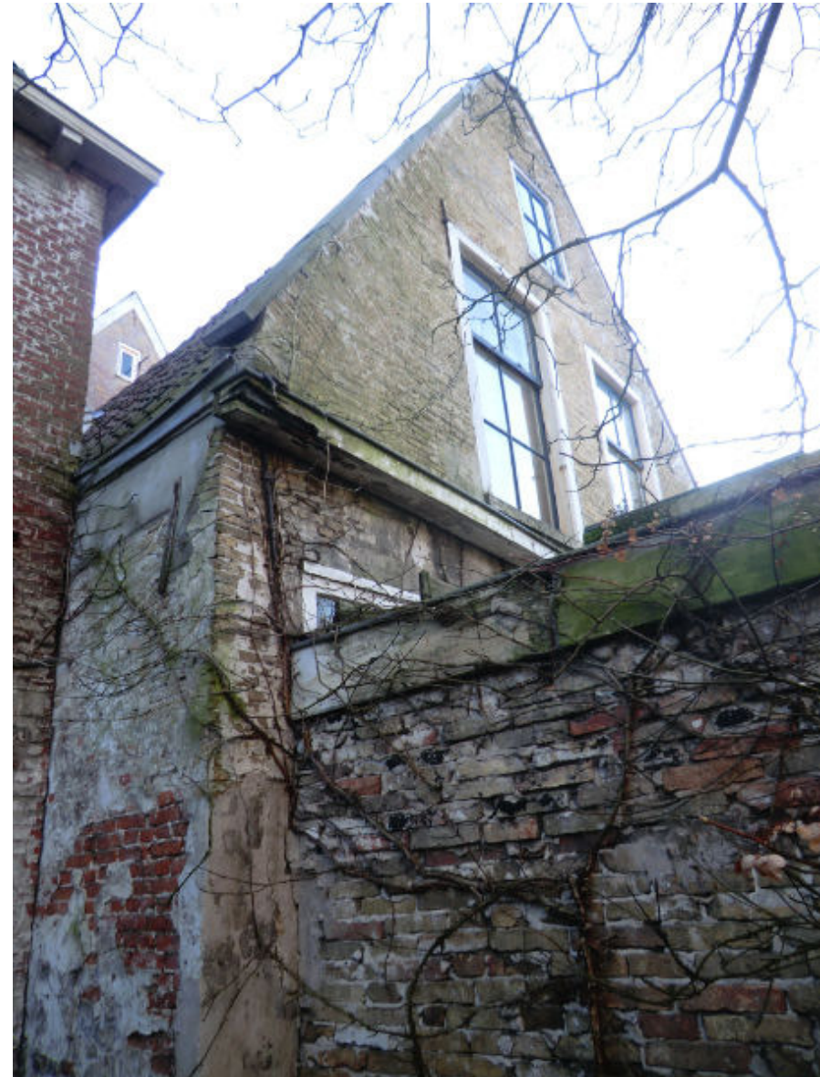
Achterhuis: achtergevel met klezortjes en zijgevel oost in rode baksteen en Friese geeltjes
