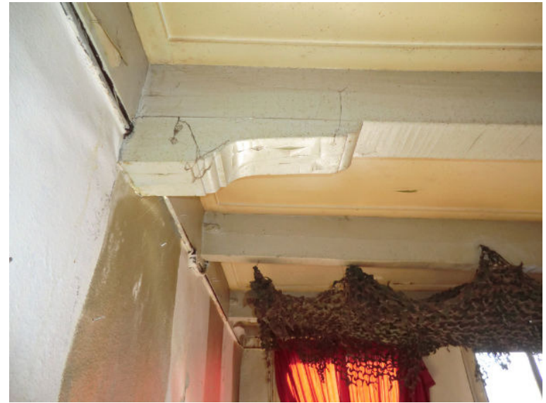
Bouwdeel A, voorkamer verdieping: sleutelstuk
