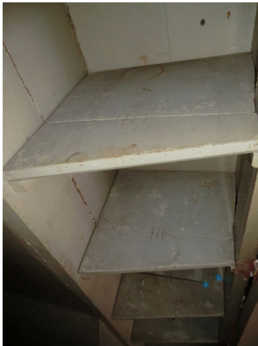
Bouwdeel A: kast in voorkamer met telmerken IIII, III en II (V en I zitten erboven en onder)
