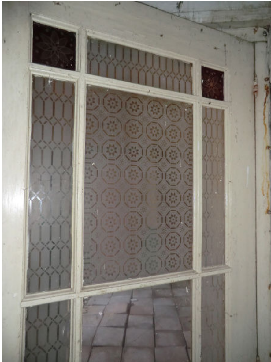
Bouwdeel A, achteringang: detail van deur met mousselineglas
