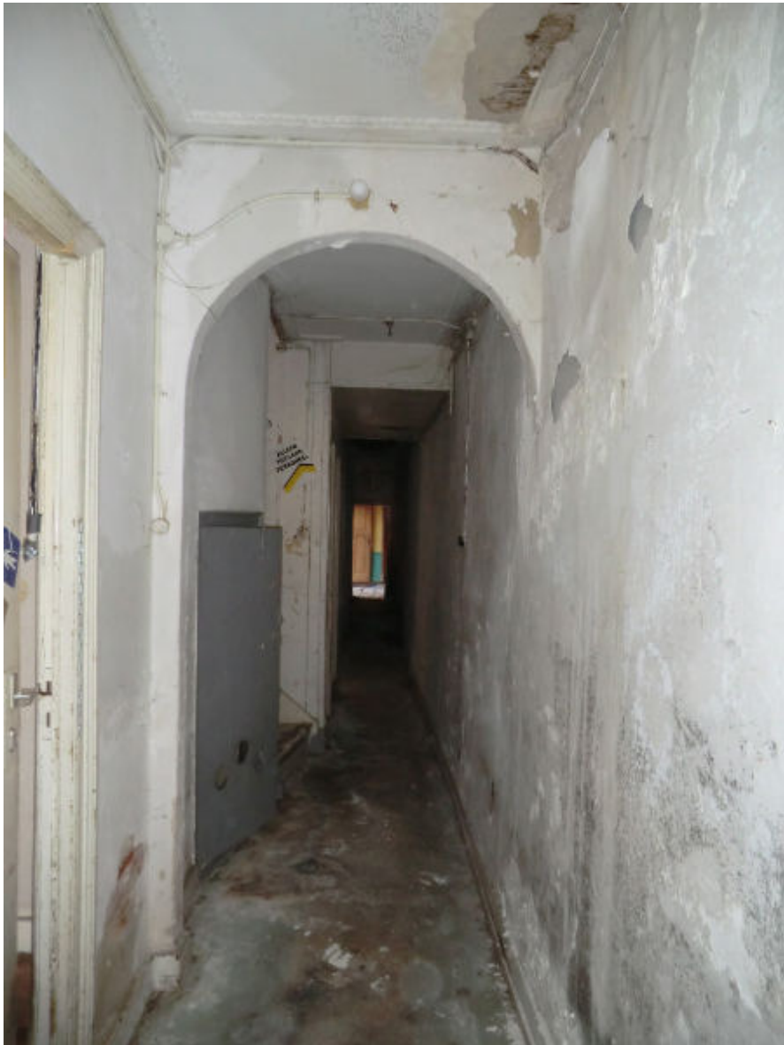
Bouwdeel A: Langsgang met rondboogdoorgang, kelderdeur en zicht op bouwdeel B
