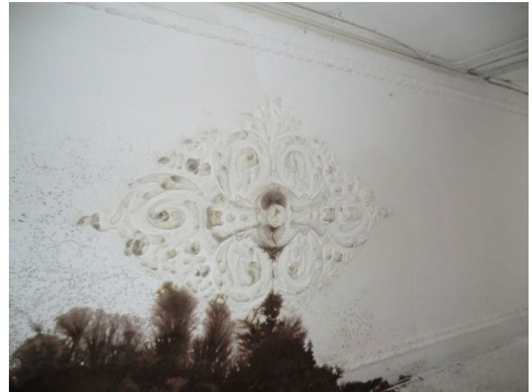
Bouwdeel A: plafond met ornament en eierlijst in gang
