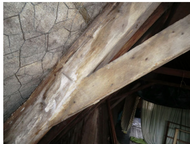
Detail kapconstructie: gebeiteld telmerk I op spantbeen
