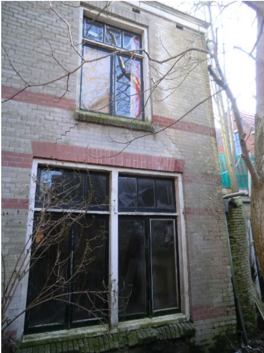
Bouwdeel C: westgevel
