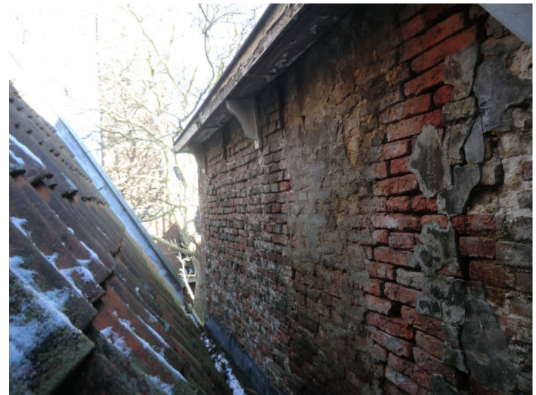
Bouwdeel A: zijgevel west
