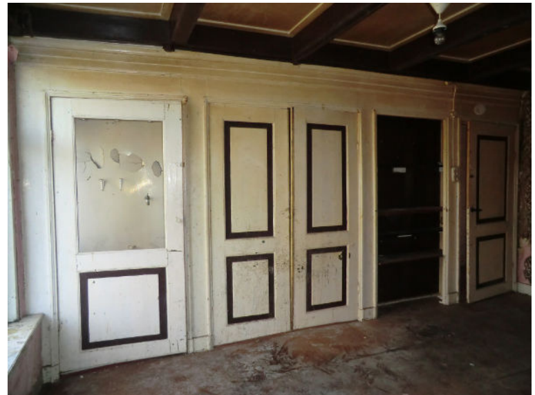
Bouwdeel A, achterkamer verdieping: bedsteewand (1840-1856)
