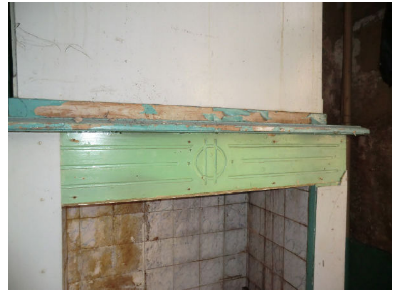
Bouwdeel C, begane grond: detail schouw met jugendstildetailering
