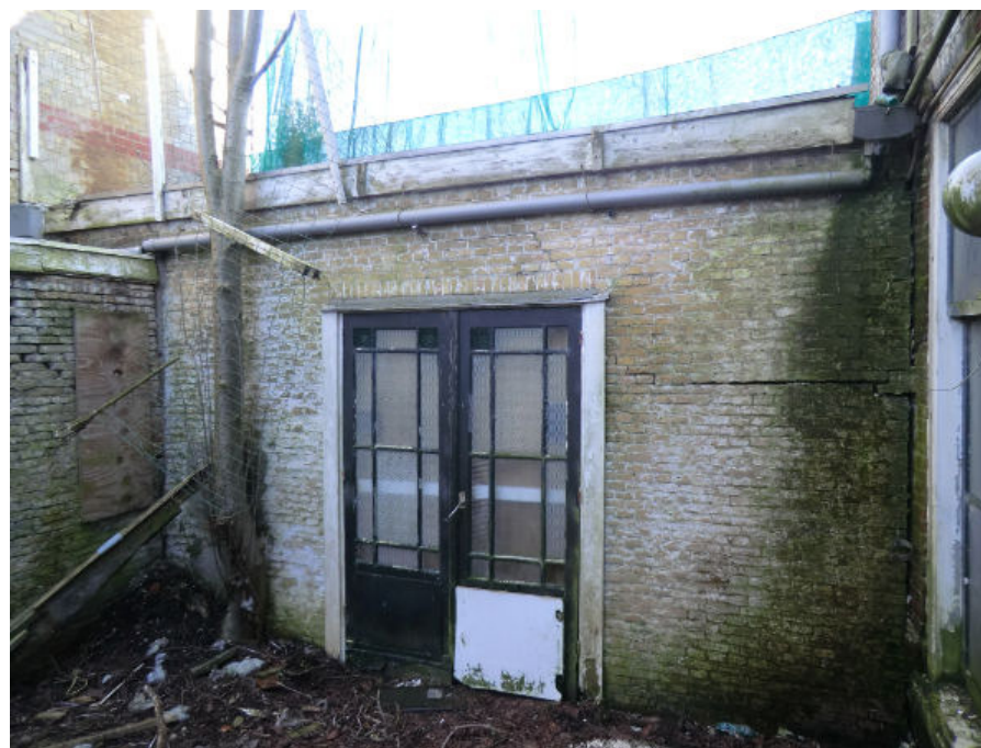
Bouwdeel B: westgevel: tuindeuren met mousselineglas en fragment van het toilet (links)
