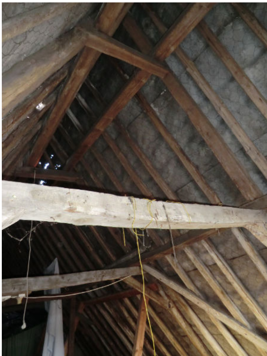
Bouwdeel A: kapconstructie zolder
