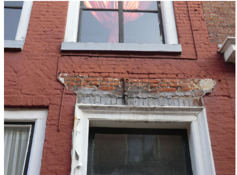
Bouwdeel A: detail voorgevel zuid met togen op zandstenen aanzetstenen
