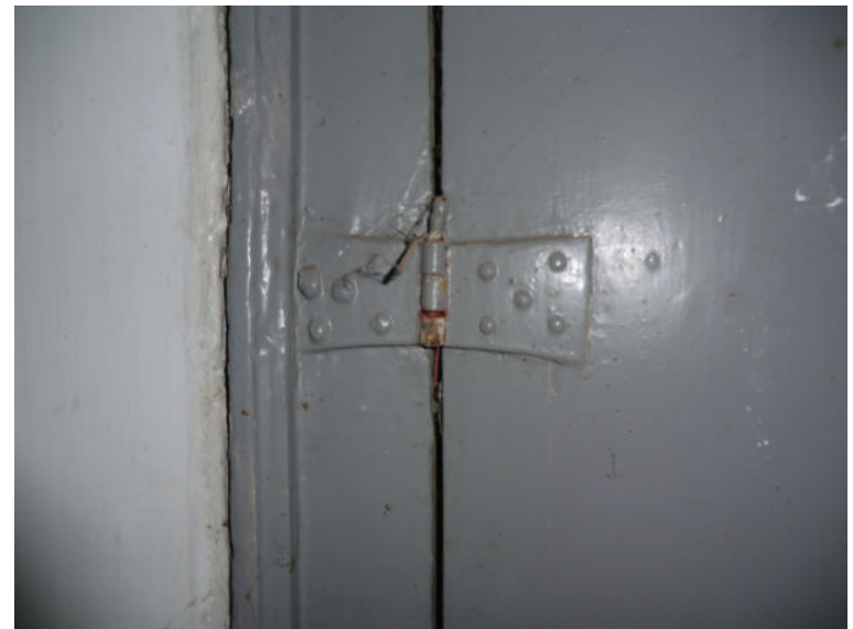
Bouwdeel A: detail kelderdeur met oplegger (scharnier)
