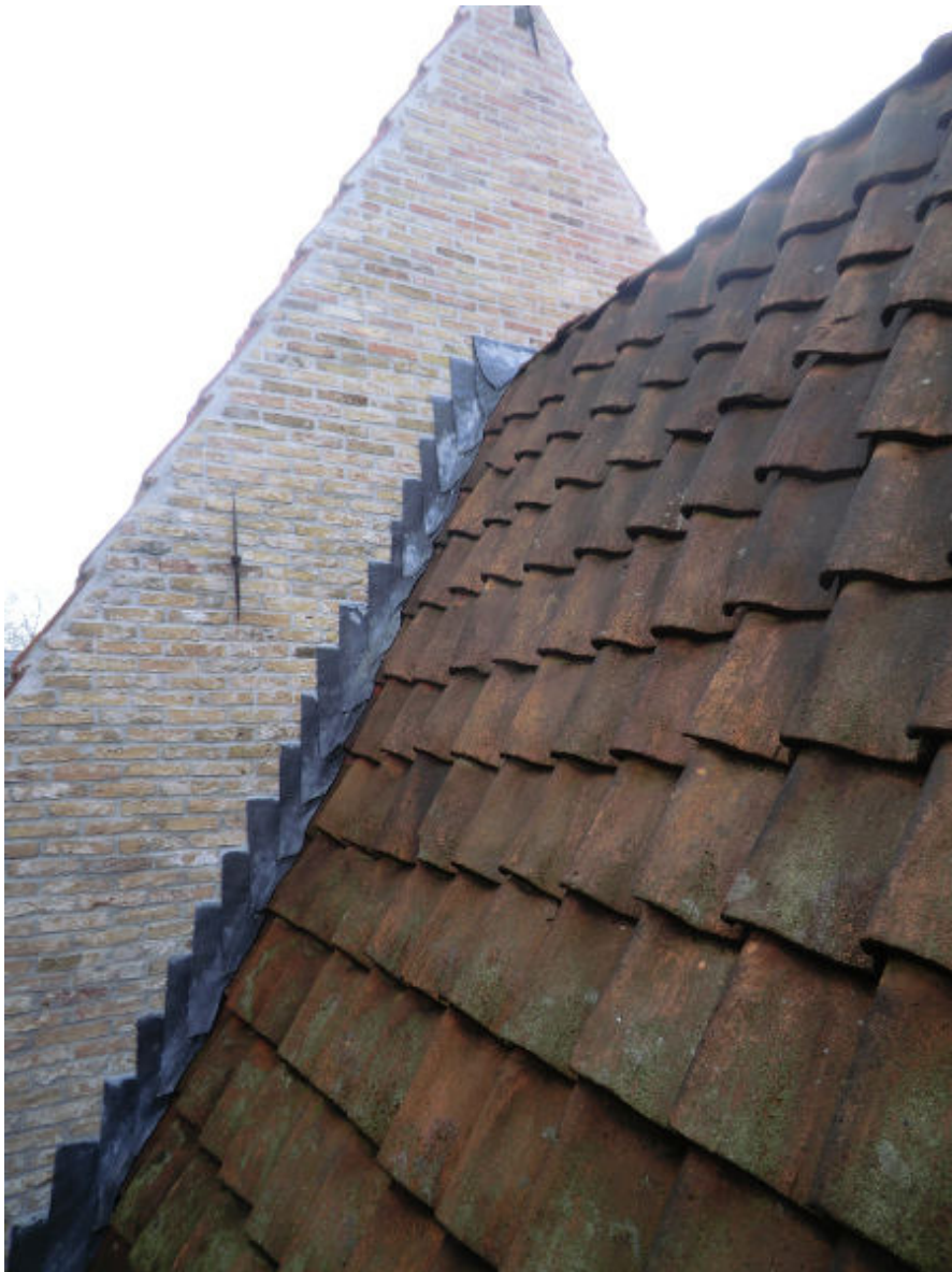
Bouwdeel A: achtergevel noord en de linksdekkende pannen op het achterhuis
