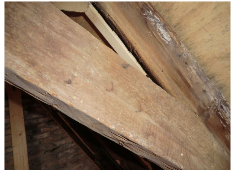
Kapconstructie voorhuis: gebeiteld telmerk op een korbeel
