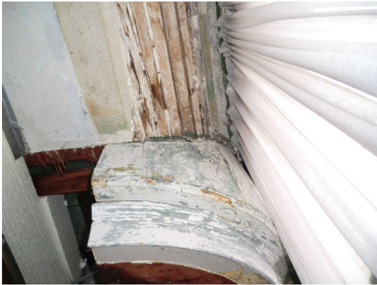
Bouwdeel A, begane grond: oude etalage achter voorgevel
