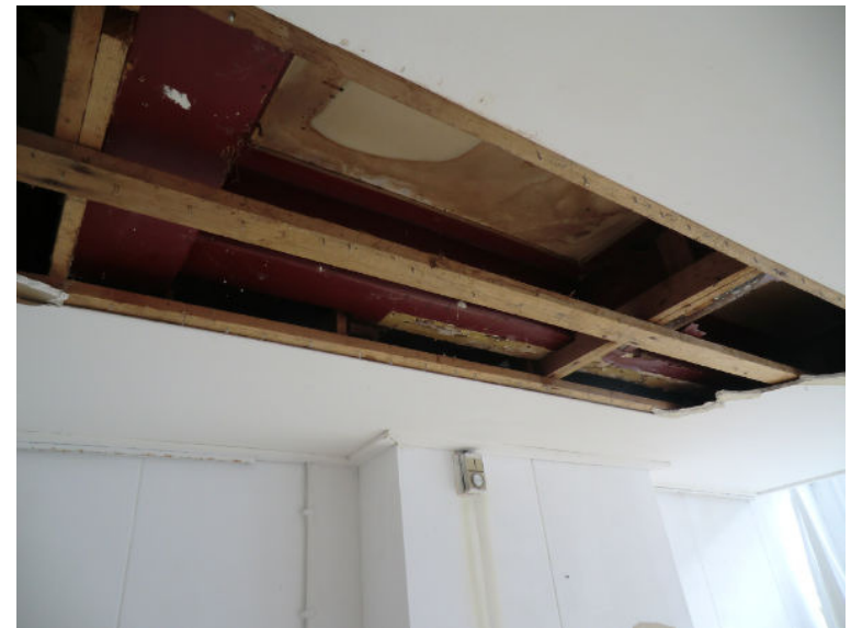
Bouwdeel A, verdieping, voorkamer: raveling en grenen balklaag
