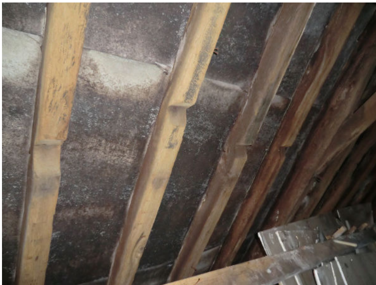
Kapconstructie achterhuis: hergebruikte eiken sporen met oude inkepingen
