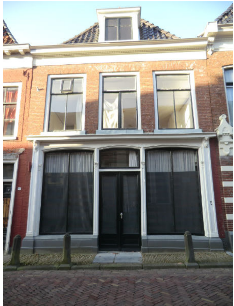
Bouwdeel A: voorgevel zuid
