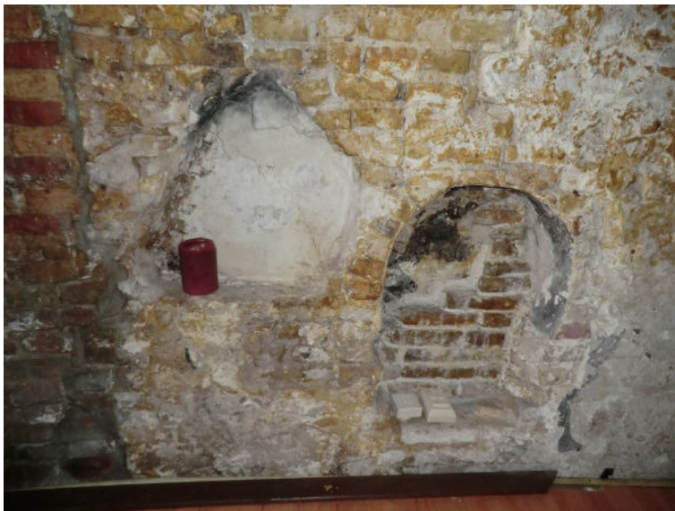
Zijgevel oost, verdieping, detail met nissen
