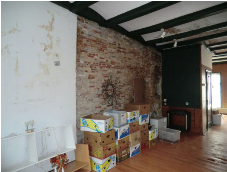
Zijgevel oost, verdieping: oorspronkelijk muurwerk (1630-1650)
