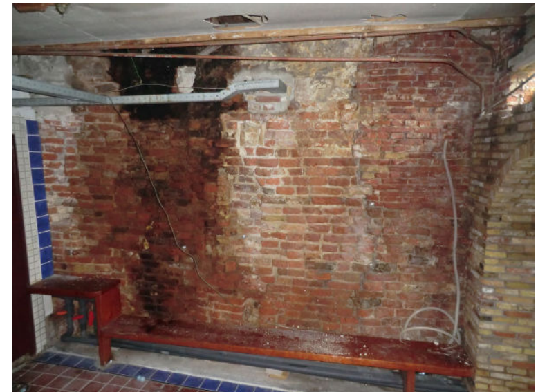
Zijgevel west, begane grond: mogelijk deels oorspronkelijk middeleeuwse muur
