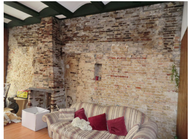
Zijgevel west, verdieping: oorspronkelijk muurwerk met borstwering 19 e eeuw
