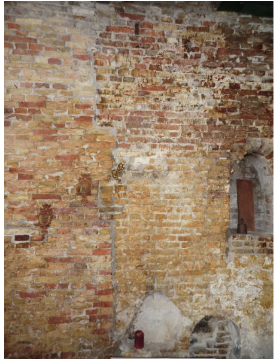
Zijgevel oost, verdieping: detail bloktand (rechts: 1630-1650; links 1760-1772)
