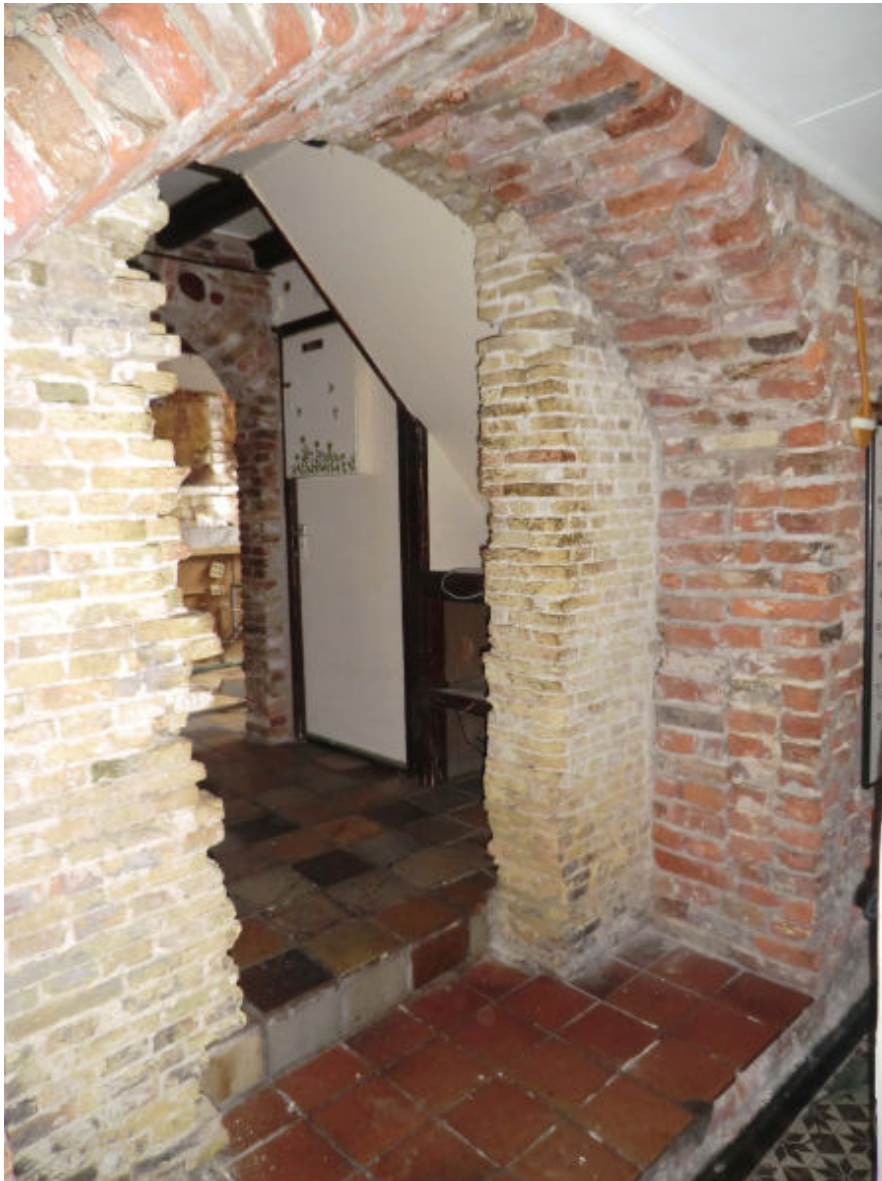
Zijgevel oost, begane grond: ozendrop is dichtgemetseld met hergebruikte kloostermoppen
