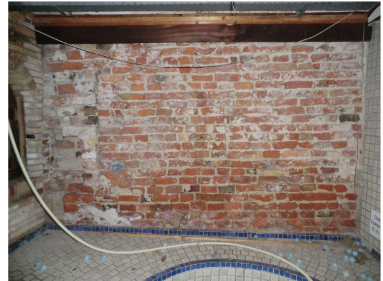
Zijgevel oost, begane grond: muurwerk met hergebruikte kloostermoppen
