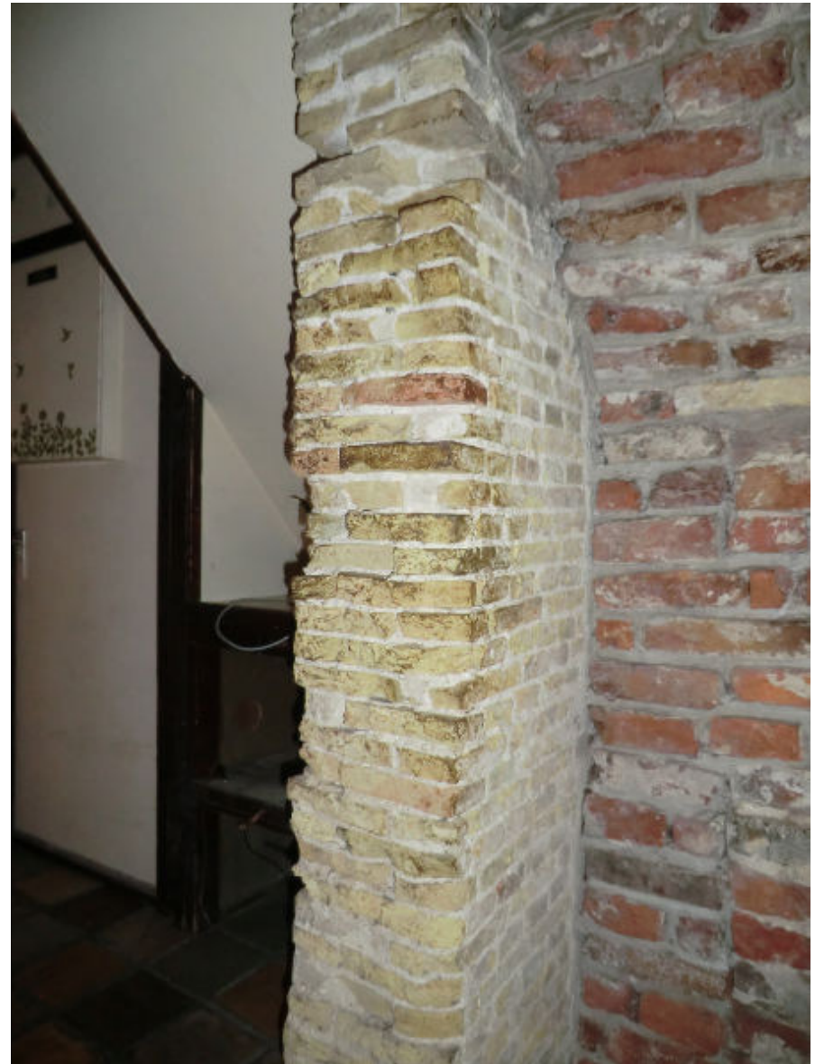
Bouwdeel A: zijgevel oost in anderhalfsteens verband, naast dichtgemetselde ozendrop
