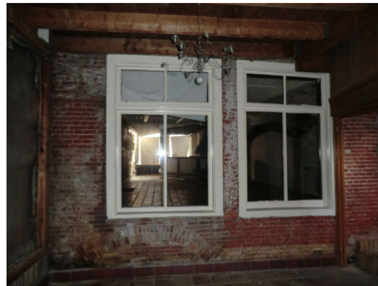
Bouwdeel A: achtergevel noord, begane grond
