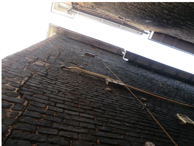
Bouwdeel A: bloktand tussen voorgevel(19 e eeuw) en zijgevel oost (16 e eeuw)
