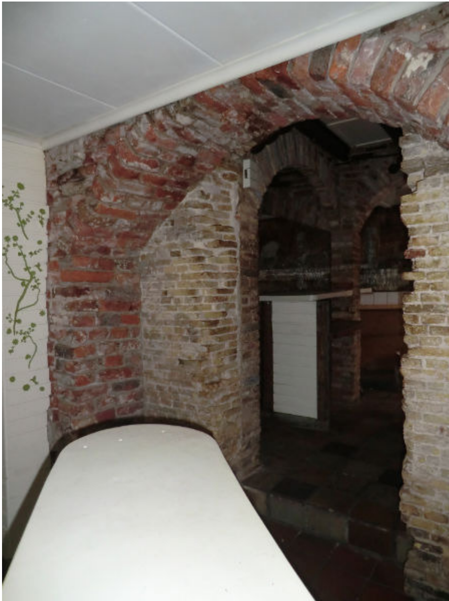
Bouwdeel A, vanuit buurpand: zijgevel west in Friese geeltjes
