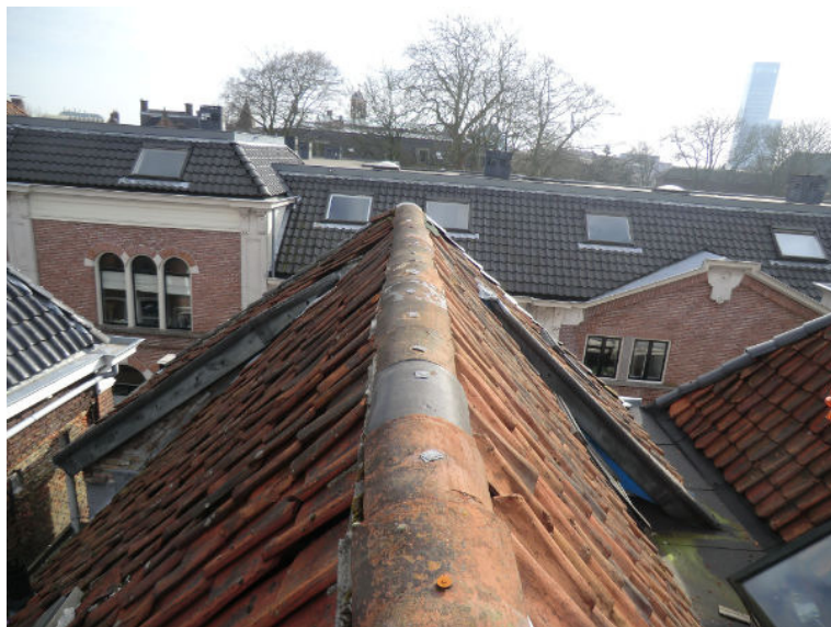
Bouwdeel A: samengesteld zadeldak met voorschild
