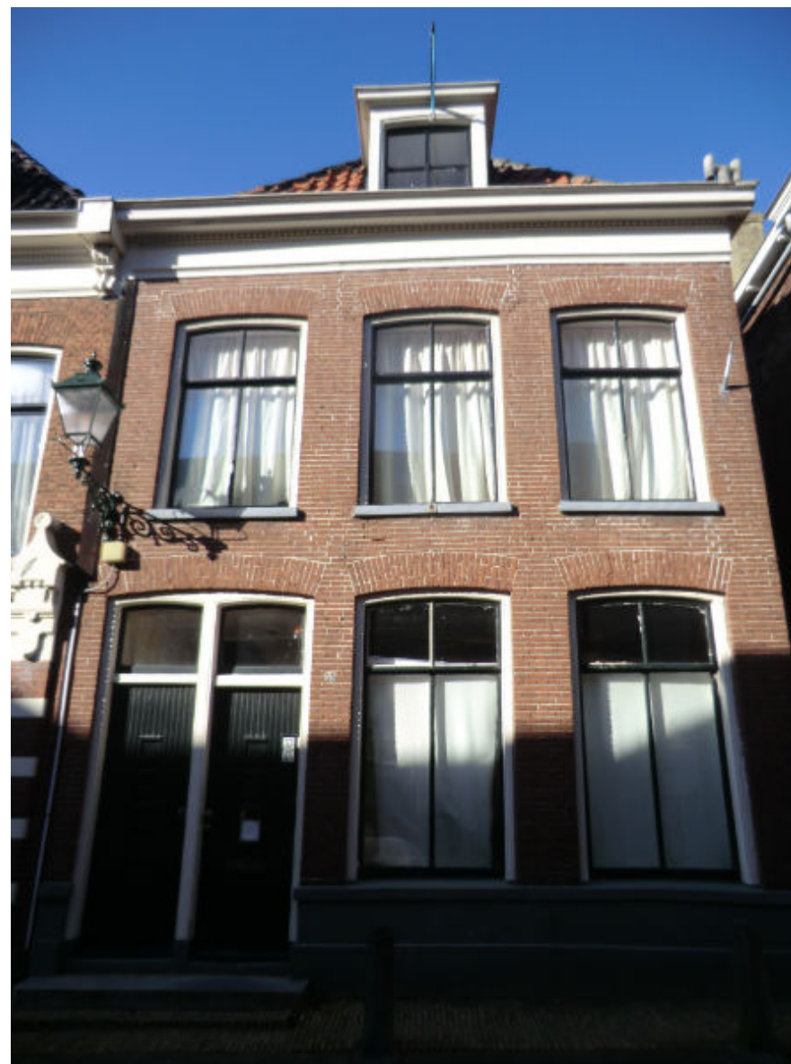
Bouwdeel A: voorgevel zuid
