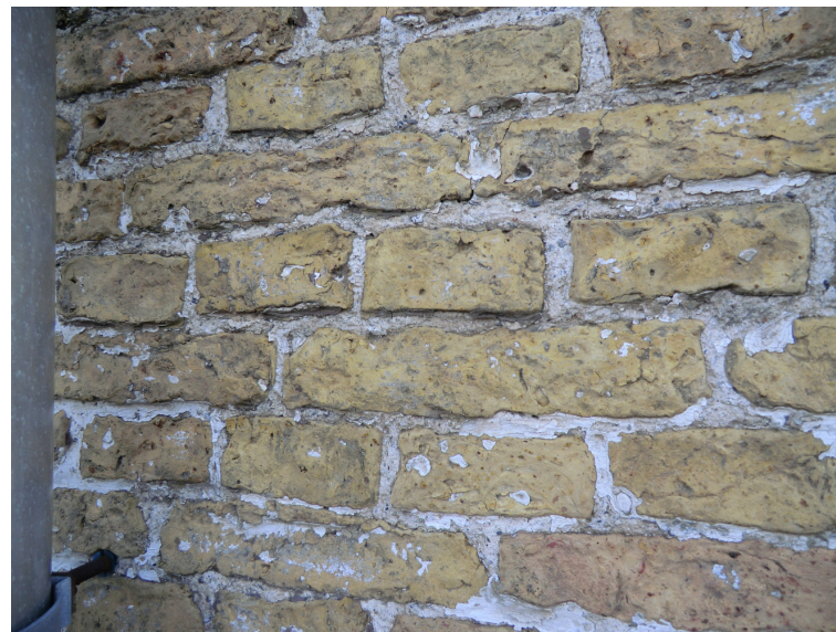
Detail achtergevel, geveltop: Friese geeltjes met schelpjes.
