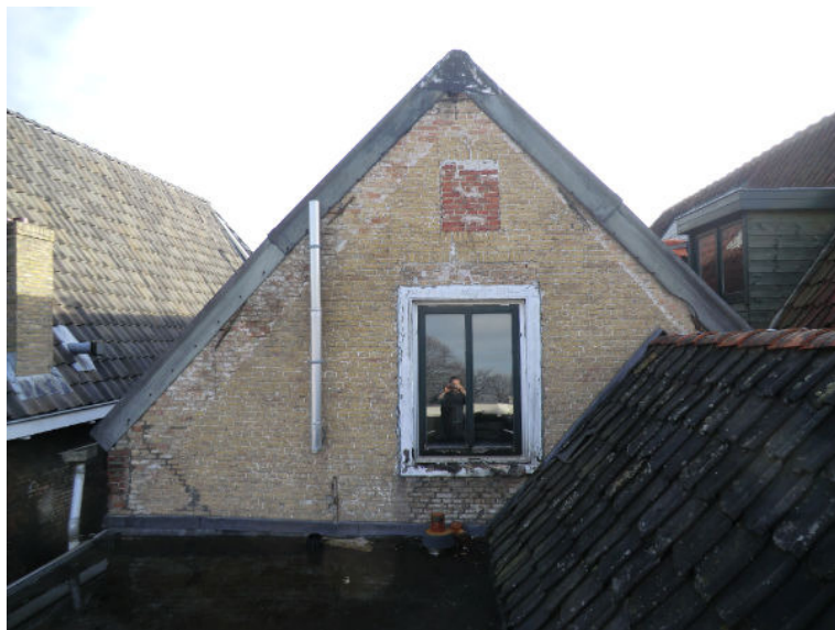
Bouwdeel A: achtergevel noord, ter hoogte zolderverdieping
