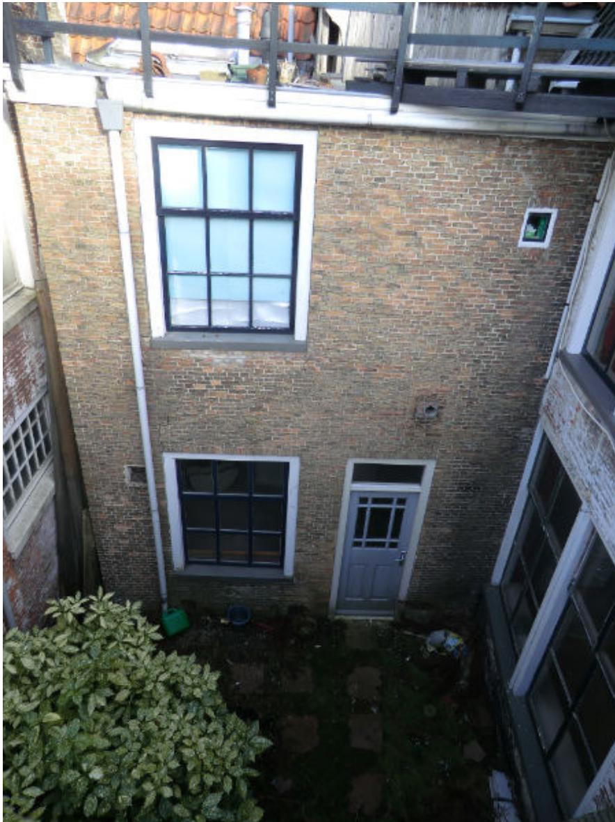
Bouwdeel B: zijgevel west
