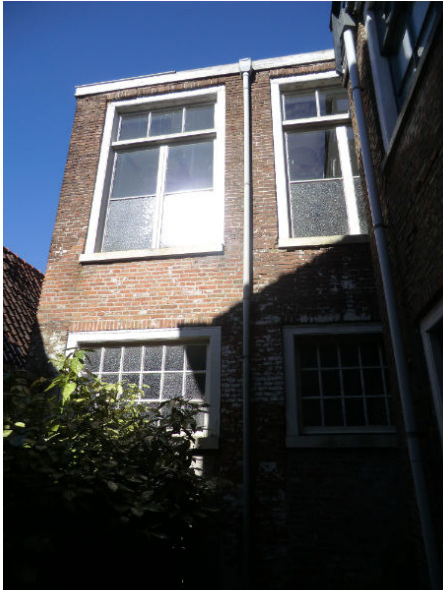
Bouwdeel C: voorgevel zuid
