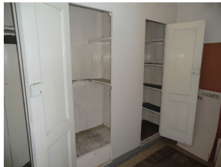
Bouwdeel C: verdieping met kastwand tegen westgevel
