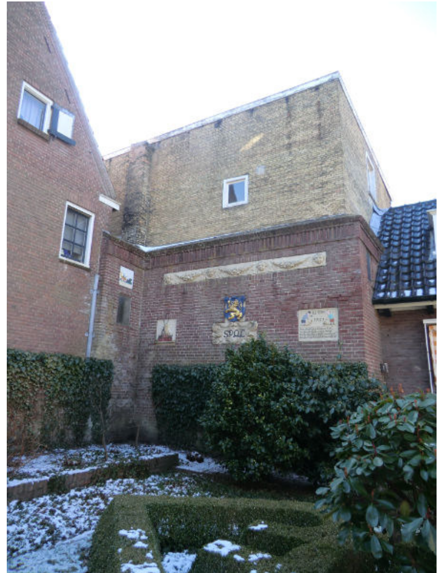
Bouwdeel C: zijgevel oost vanuit de Pijlsteeg, met tuinmuur ter hoogte van de begane grond
