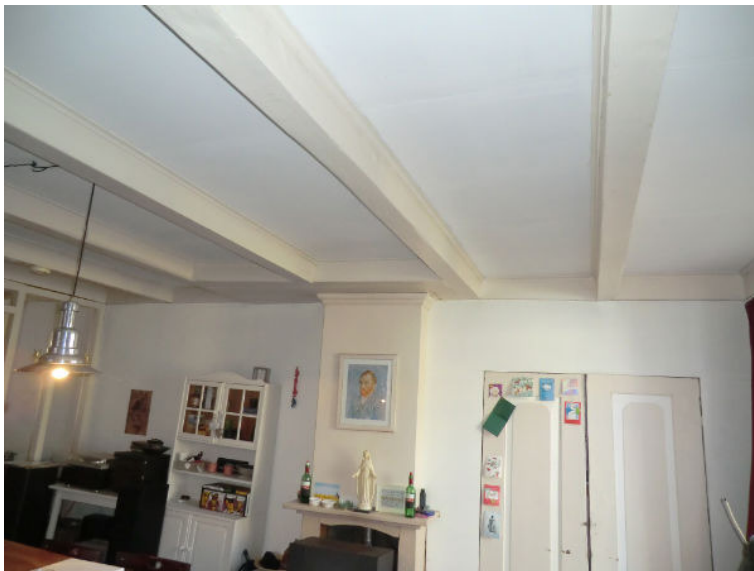
Verdieping: achterkamer met kast, schouw en boezem en trekbalen
