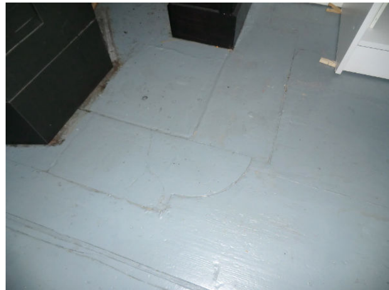
Verdieping: voorkamer met aftekening in vloer van oorspronkelijke stenen haardplaats
