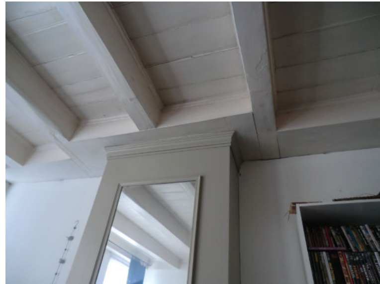
Verdieping: voorkamer met boezem en grotere raveling oorspronkelijke haardplaats
