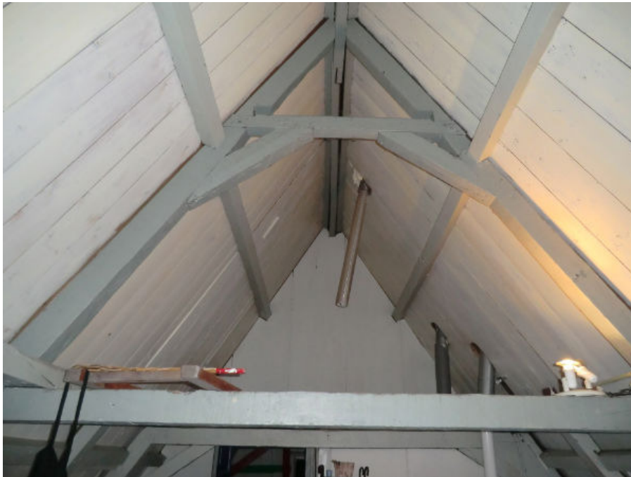
Kapconstructie met dekbalk, haanhout, korbeels, inkepingen fliering en gordingen.
