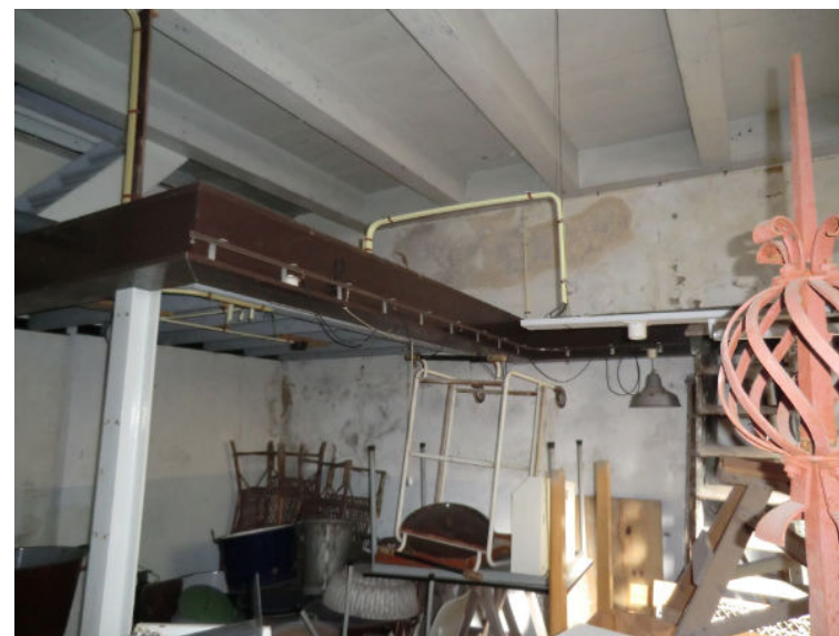
Bouwdeel C: begane grond met trekbalen, steektrap en ravelingen
