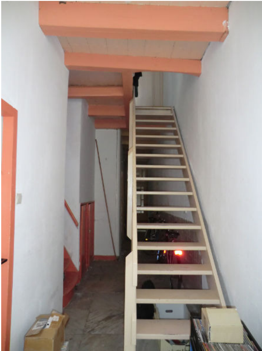
Begane grond: langsgang met trekbalken en steektrap
