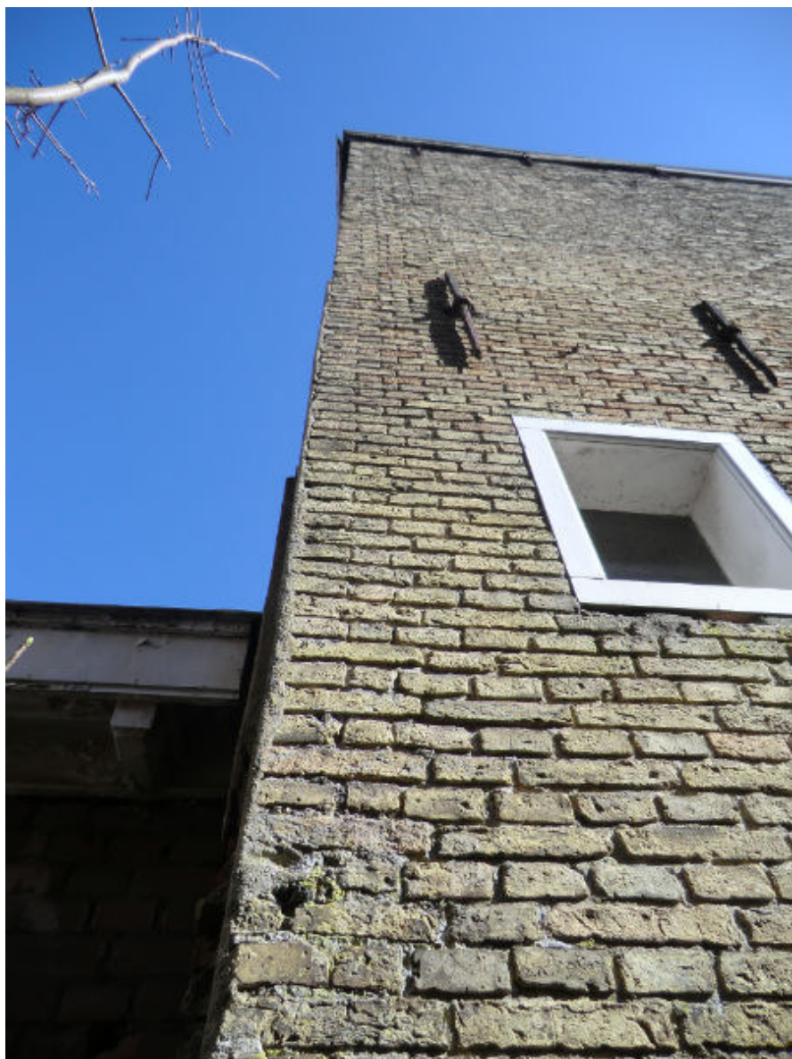
Bouwdeel C: zijgevel west, hoek met achtergevel met kwartklezootjes van onder tot boven
