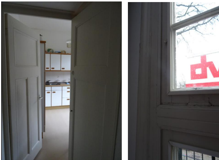
Begane grond, 1917: paneeldeuren van de keuken en de kelder en afwerking gevelopening.
