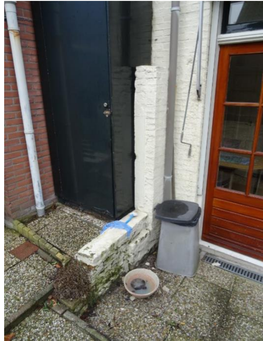
Restant van de oude oostgevel van de plantenkas uit 1913.
