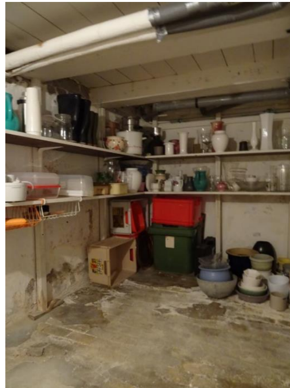
Impressie van de kelder.
