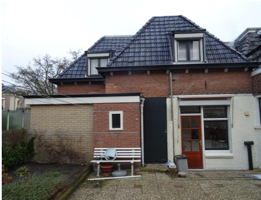
Achtergevel zuid, met links de latere aanbouwen van het portaal (1988) en een toilet (1974).
