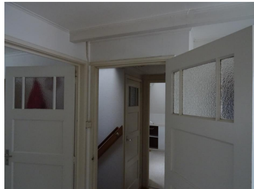
Verdieping met indeling en afwerking uit 1974.
