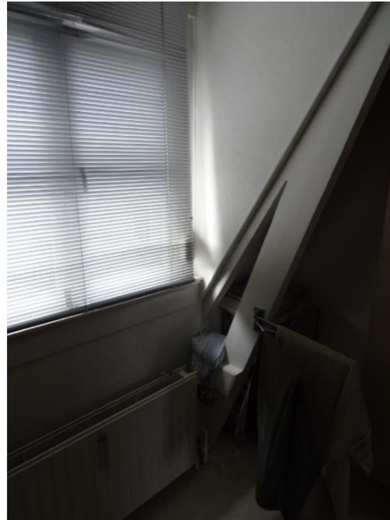
Spant op de verdieping met kreupele stijl en blokkeel.
