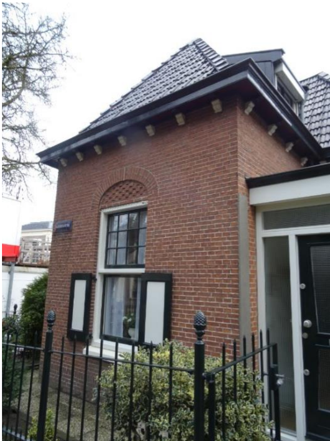
Zijgevel west, met een deel van het portaal uit 1988.
