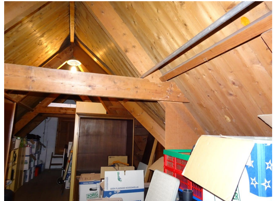
Zolder zwakkenkamers: kapconstructie uit 1928.
