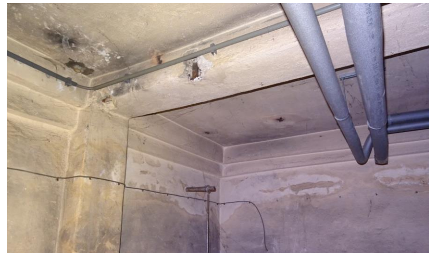
Impressie kelder Perkswaltje 26: betonnen kolommen, muurdammen en 'balklagen'.
