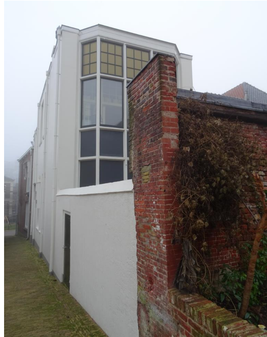
Achtergevel van het achterhuis (1913) van het voormalig weeshuis, met oudere muurdelen op de voorgrond.
