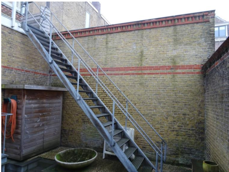
Binnenplaats achter het achterhuis van het voormalig weeshuis: muren uit 1913
