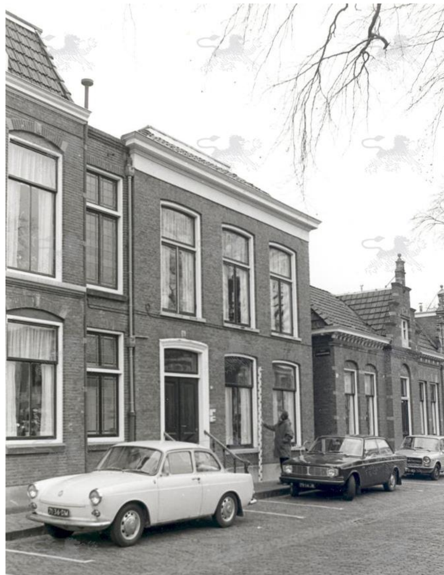
Voormalig weeshuis 1869. In 1913 verbouwd tot ziekenhuis. De voormalige Nauwe Gasthuissteeg (links ervan) werd in 1928 dichtgezet. Foto 1973. Bron: RCE.
