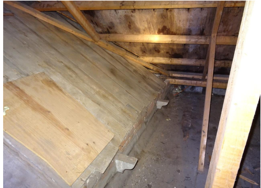
Plat dak boven de voormalige steeg en gootklossen van het voormalig weeshuis. Aan de andere zijde van de steeg zitten nog de oude bakgoten.
