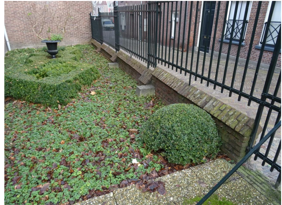
Tuinmuur (1928) aan de Pijlsteeg
