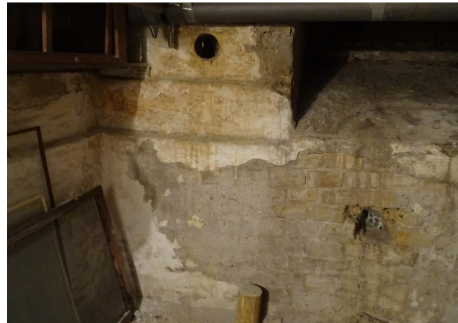
Kelder onder het voormalige weeshuis, 1869: dubbele voorsprong en diepe afzaat.
