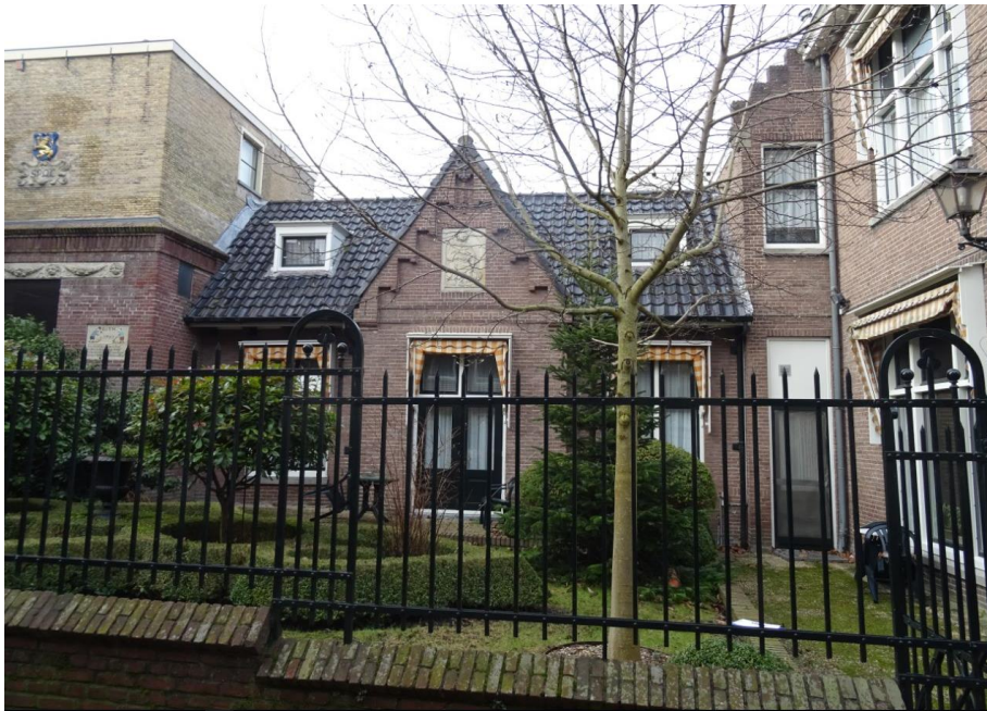
Voorgevel van de zwakkenkamers aan de Pijlsteeg
