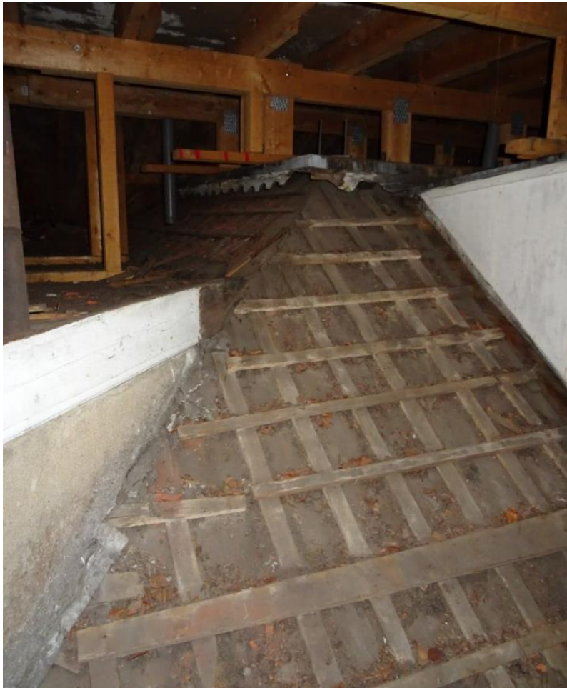
Het dak van het voormalige weeshuis, onder een vernieuwd dak van na 1988-1991.
