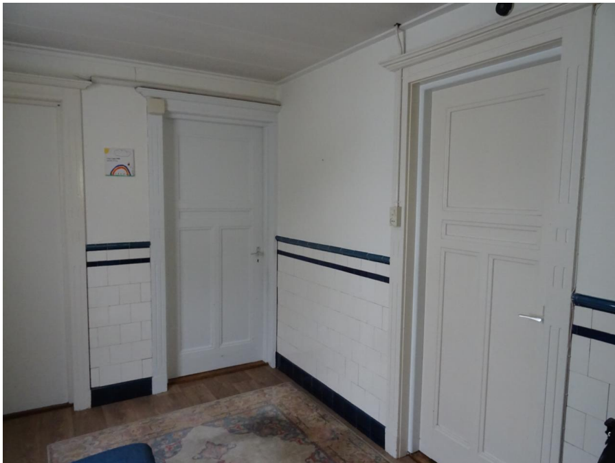
Portaal begane grond met deuren richting voormalige slaapzaal (links), dagverblijf (midden) en werkplaats (rechts). Tegellambrisering, paneeldeuren en architraaflijsten uit 1928.
