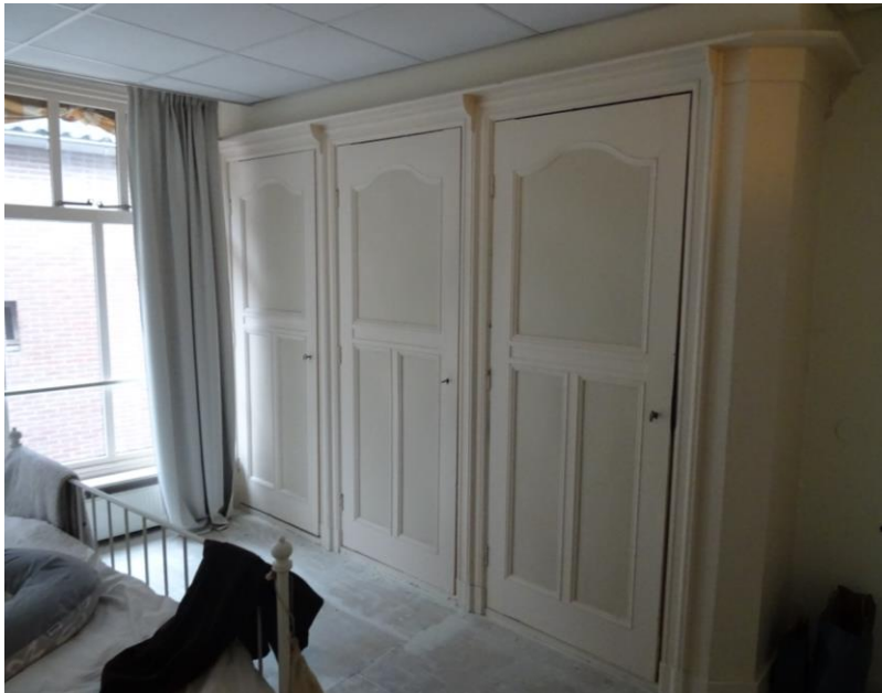
Herplaatste kastwand 1906-1910, op de verdieping.
