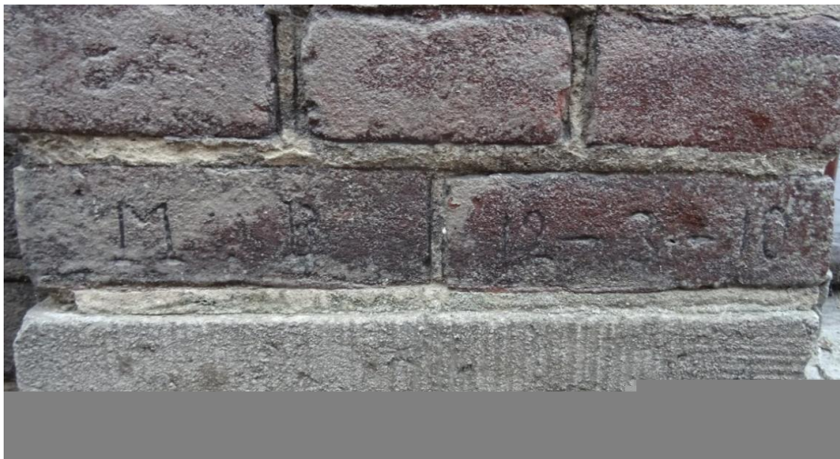
Gedateerde baksteen en baksteen met initialen: M.B. 12-3-10.
