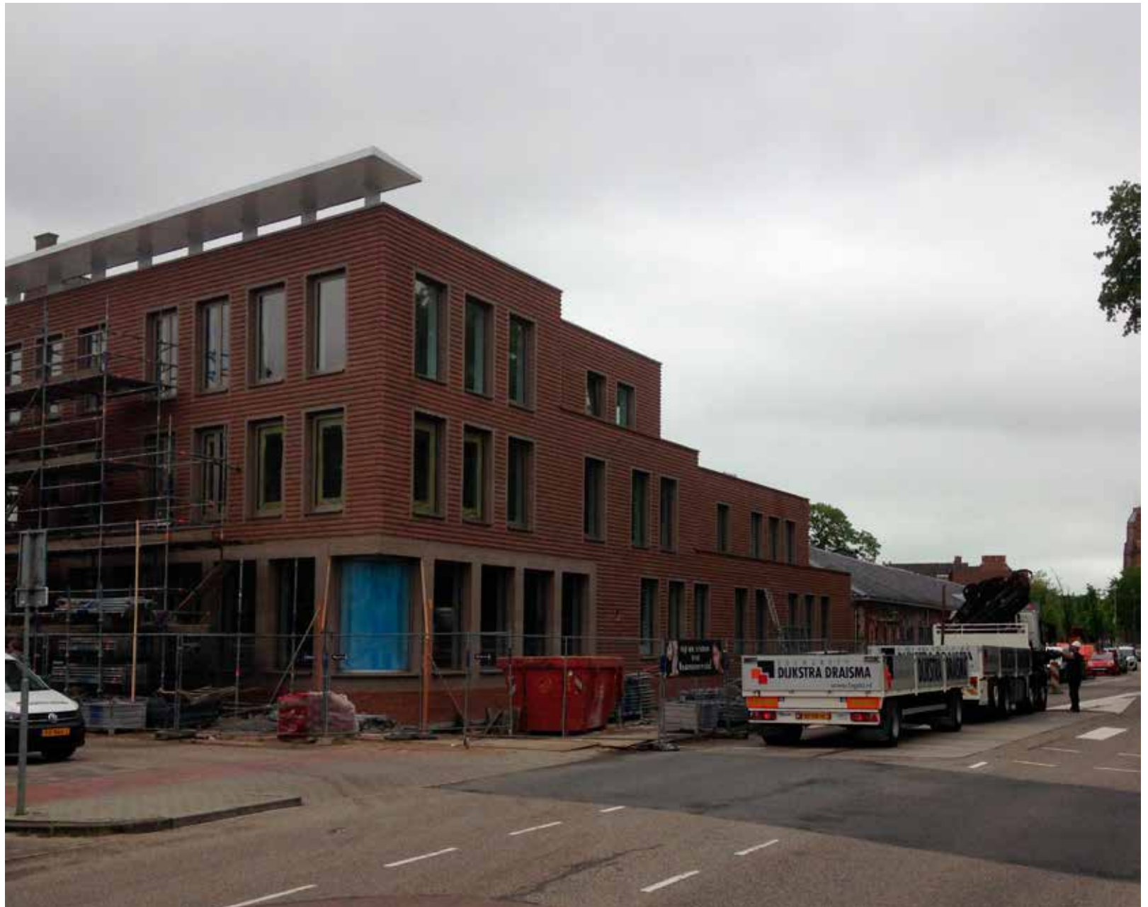
Bouwactiviteiten aan de Jellamavleugel.
