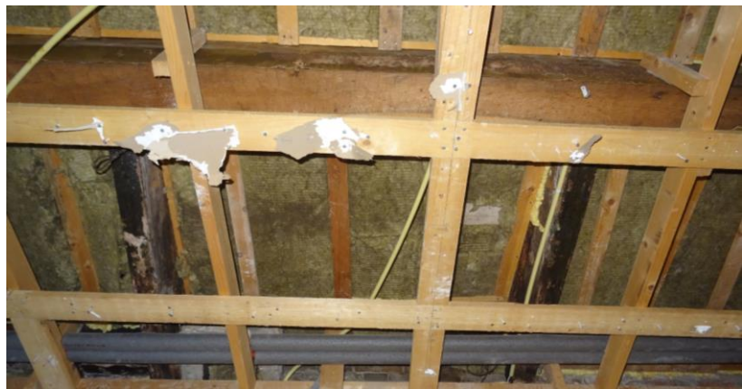
Haardravelingen aan de westgevel.
