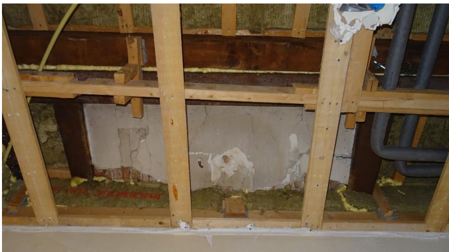
Haardtraversen en haardgewelf aan de oostgevel.
