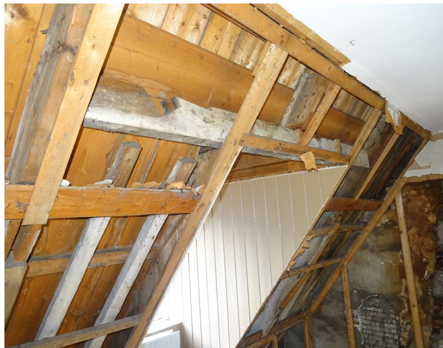
Spantbenen en afgekapte fliering van de spantbene van het voorschild.
