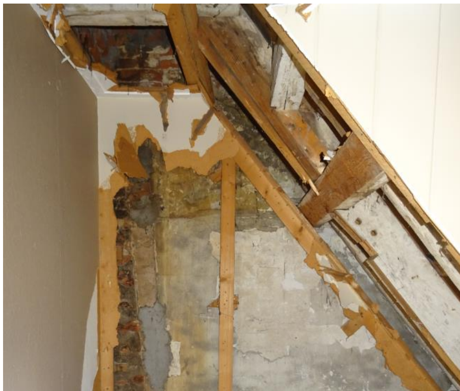
Oostgevel en kapconstructie: spantbeen met pengatverbinding en afgekapt fliering.
