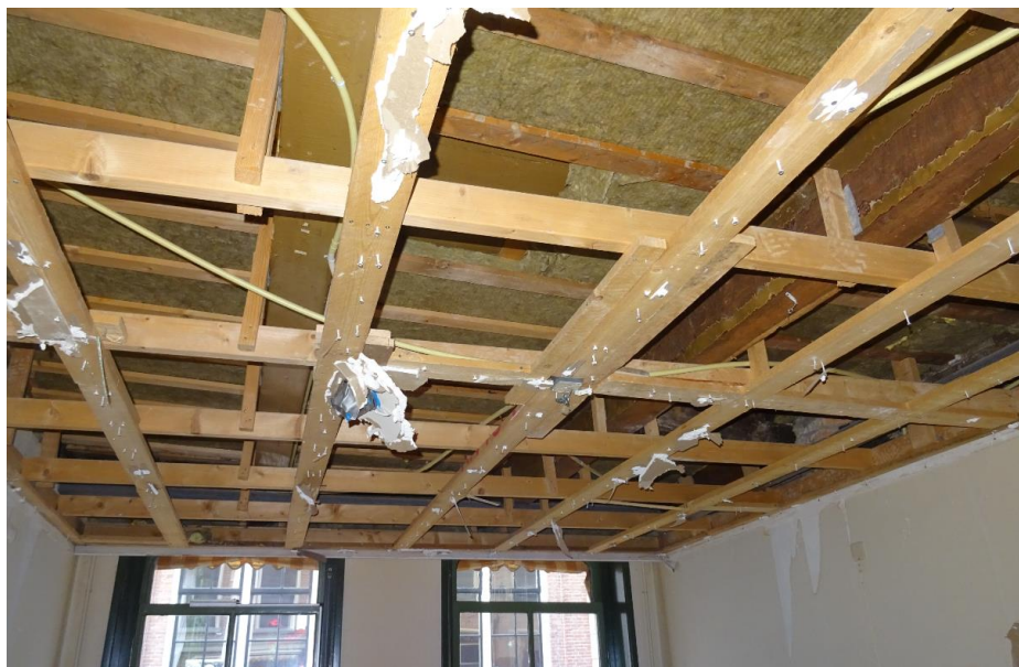
Begane grond: twee eiken balken boven de westelijke voorkamer.
