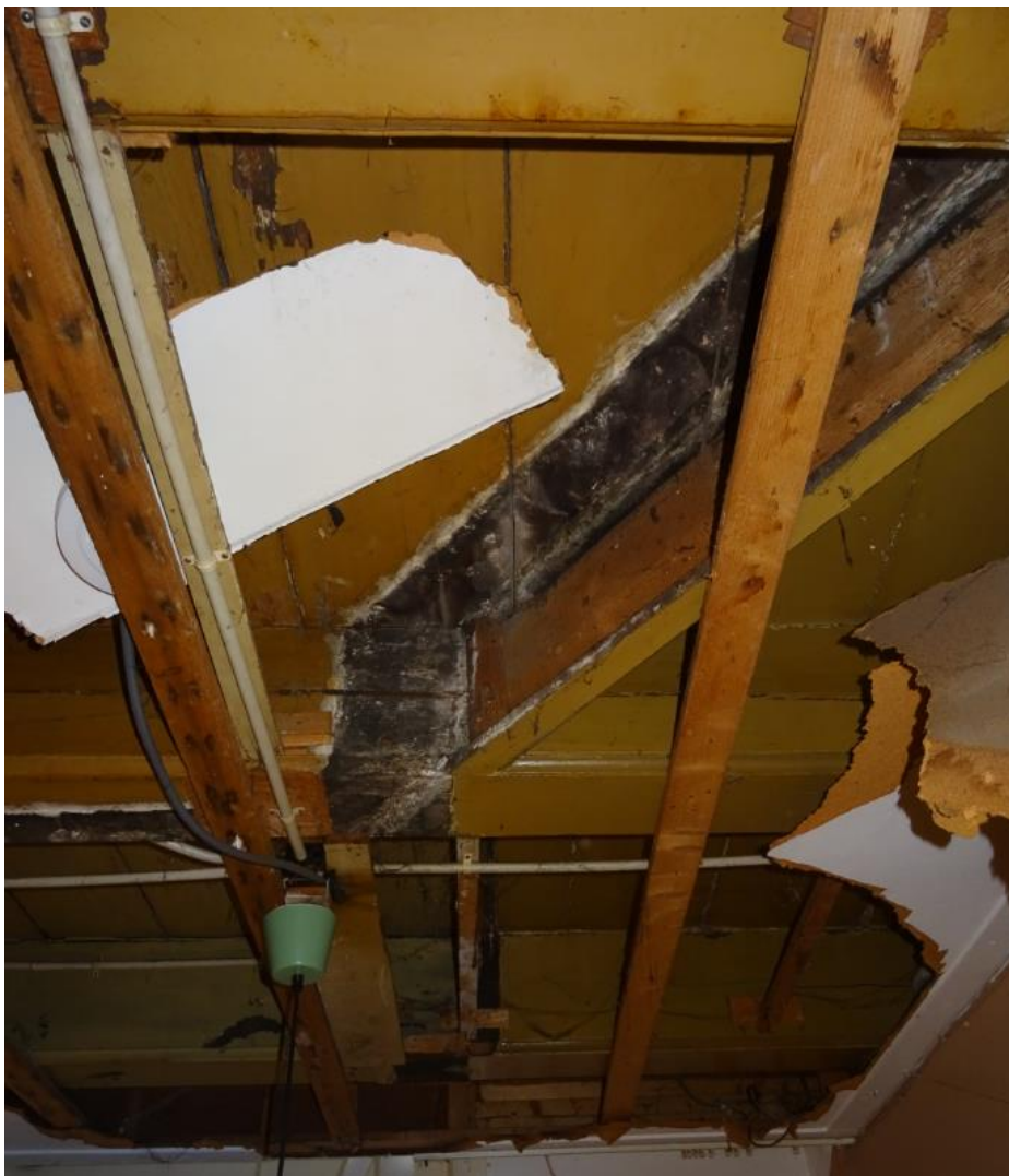
Verdieping, overloop: balklaag met aftekening oude indeling.
