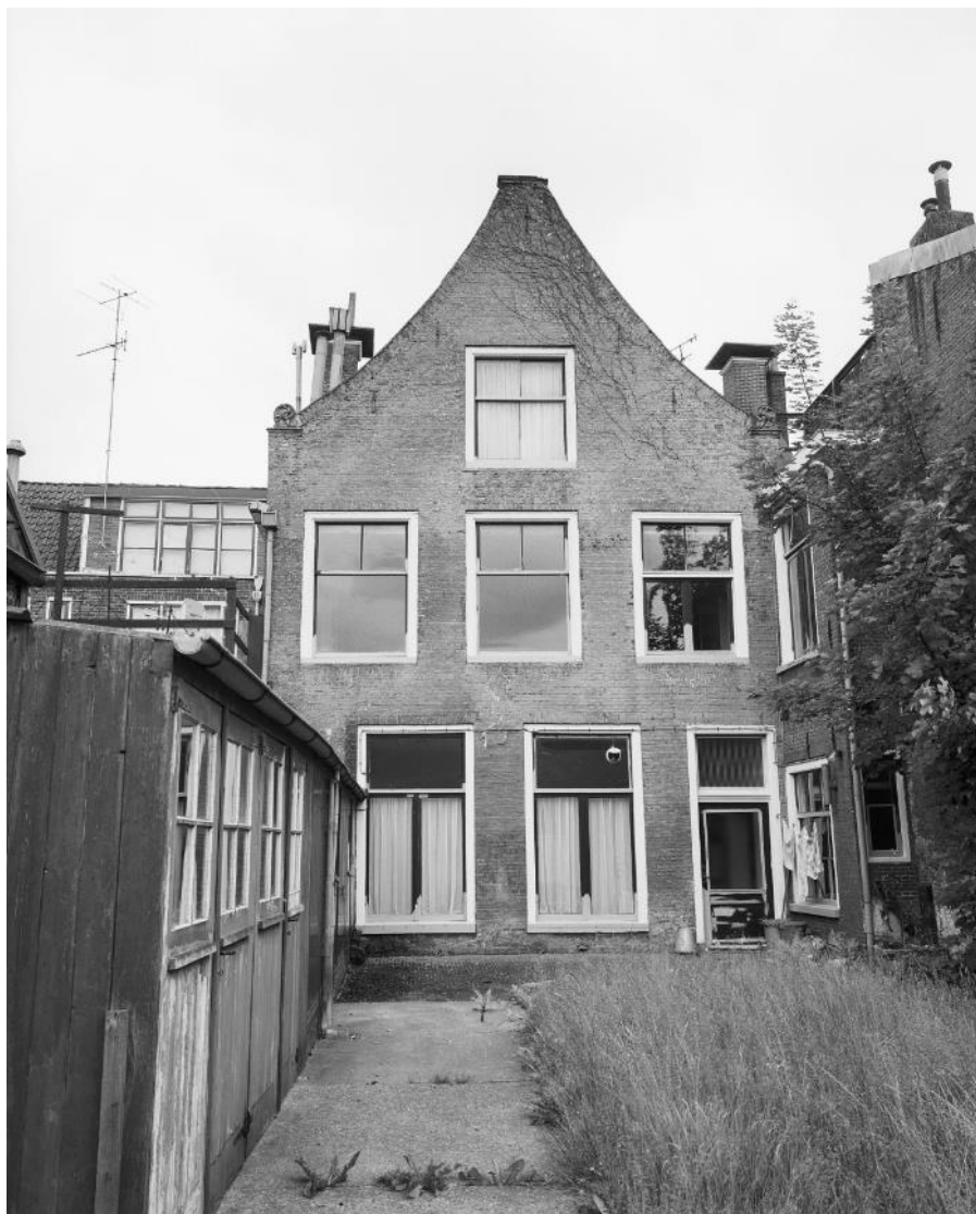
Achtergevel van Grote Kerkstraat 41, met links op de voorgrond de houten bebouwing aan de achterzijde van Wijde Gasthuissteeg 1 en 3. Links op de achtergrond het dak en de dakkapel van Grote Kerkstraat 43. Opname 1972. Bron: RCE.
