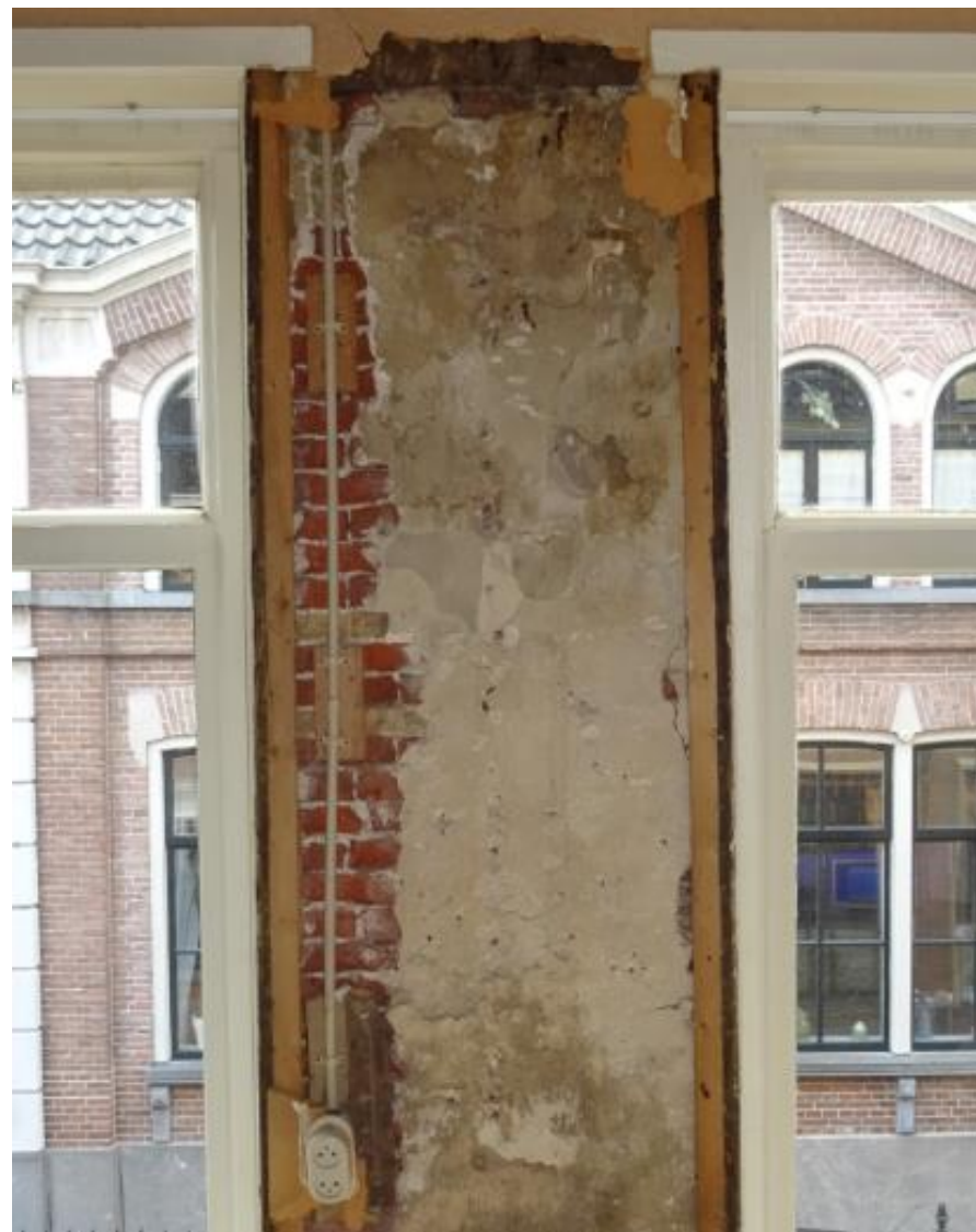
Penant voorgevel met drie speklagen. Deze speklagen komen ook voor in het andere penant.
